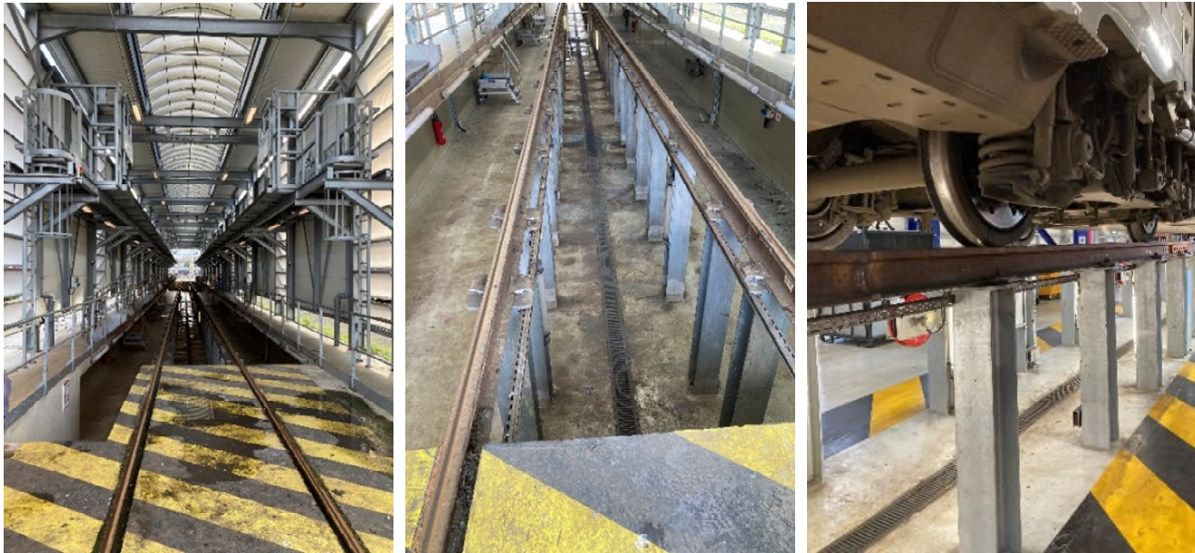
Figure 14 : Exemples de fosses pour la maintenance du matériel roulant
