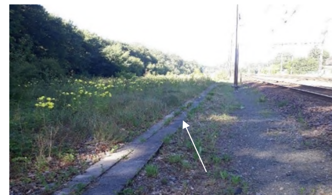
Figure 22 : Caniveau béton existant le long des voies
